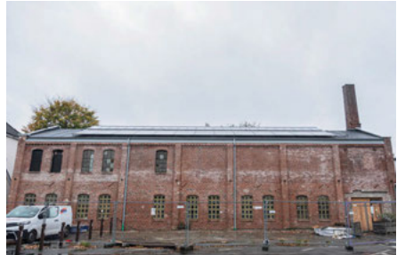
Gut an die Gebäudeoptik angepasst: Die neue Solaranlage
